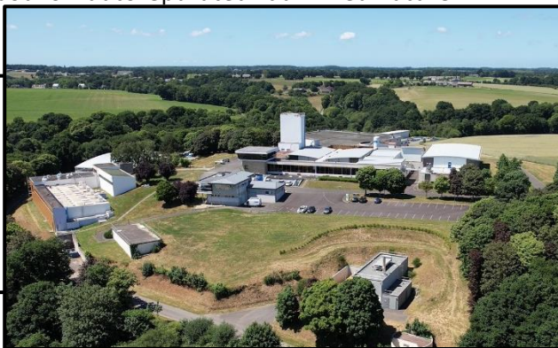
Usine de potabilisation du Syndicat Mixte Arguenon-Penthièvre à Pleven
